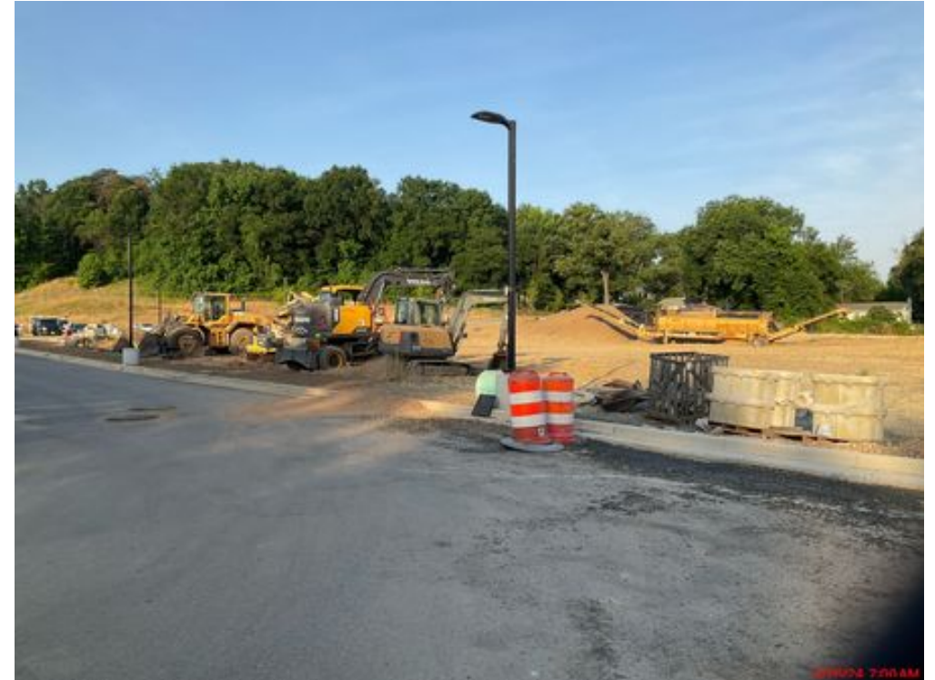
آماده سازی ساحه برای نصب دیوار حائل و میدان بیسبال
