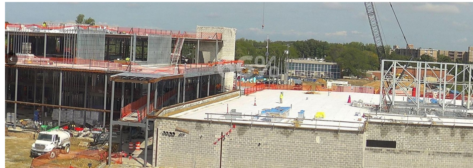
Trabajo de techado
