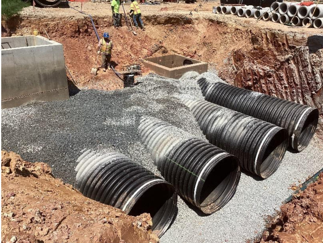
Trabajo preliminar de aguas pluviales
