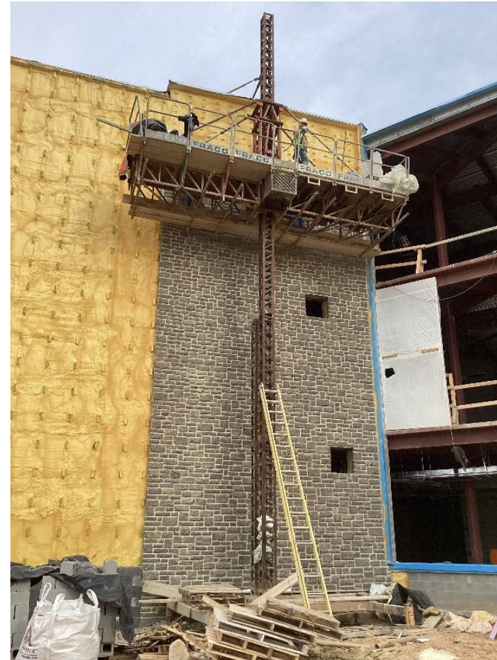
Exterior de ladrillo
