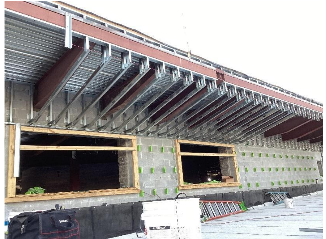
Estructura de plafón de metal
