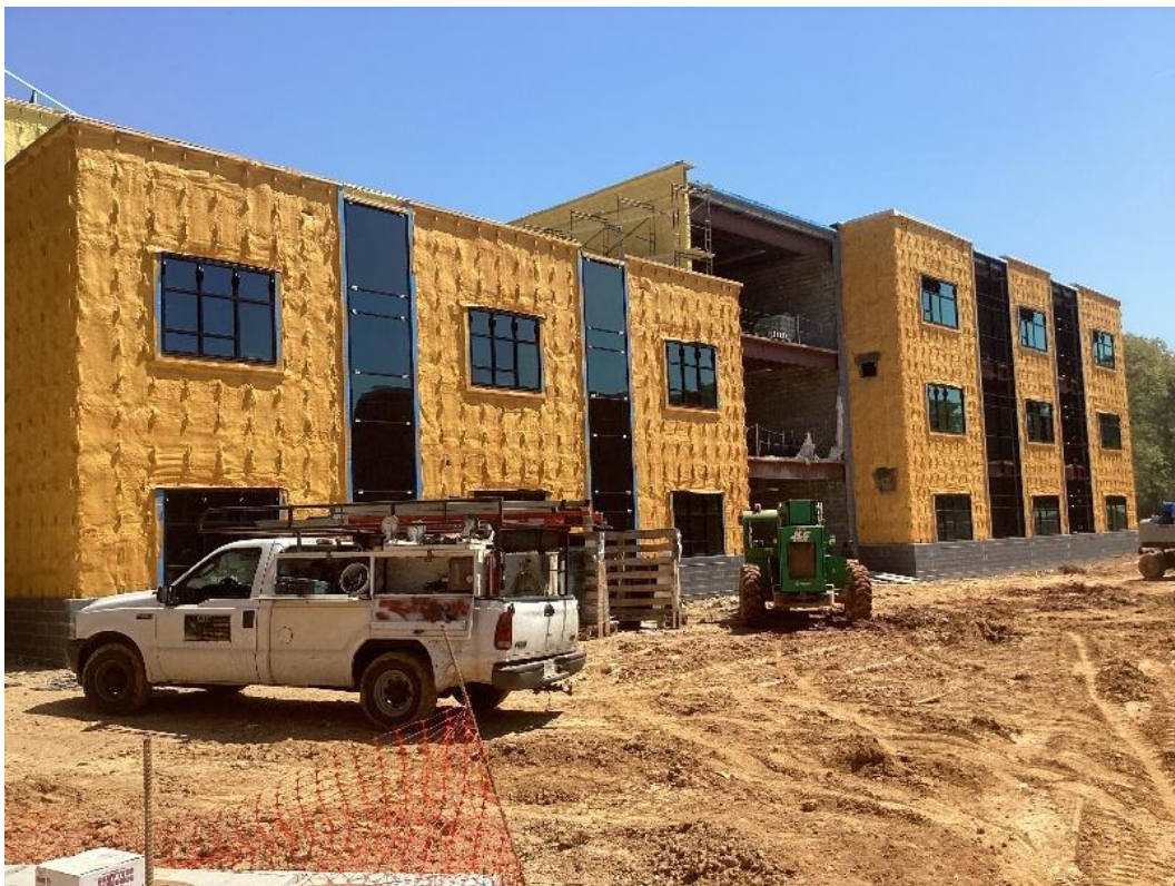
اسپری فوم، دیوارهای پرده، پنجره ها B & C - منطقه
