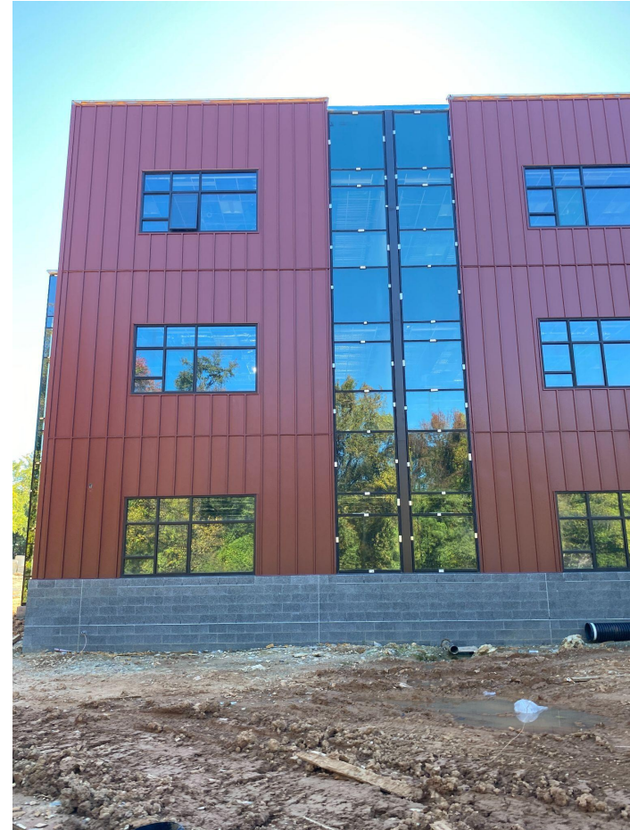
Paneles de metal en el exterior
