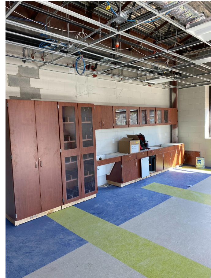
Instalación de gabinetes
