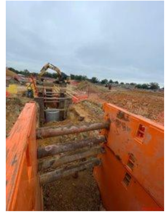
Trabajos de excavación cerca del MH 3.
