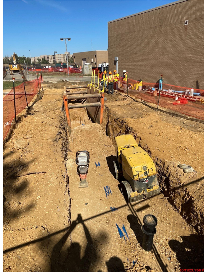
Compactación del suelo encima de la línea de agua.
