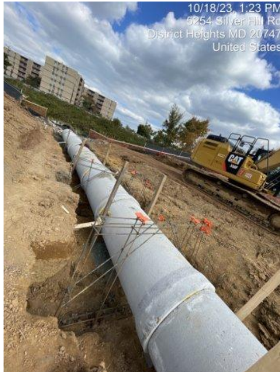
Instalación de tubería pluvial desde RS-2 hasta I-149
