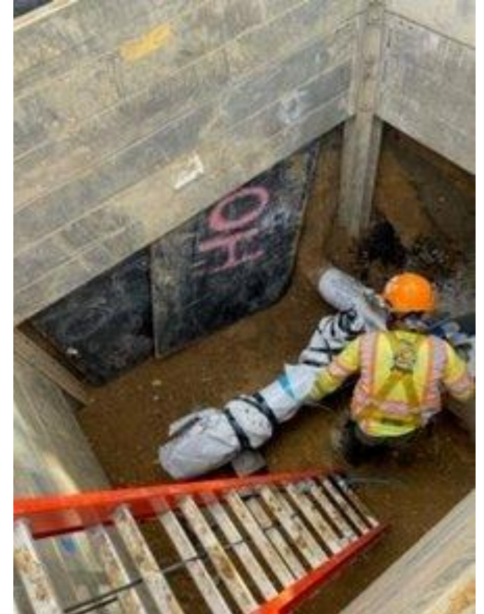
Conexión de línea de agua a existente
