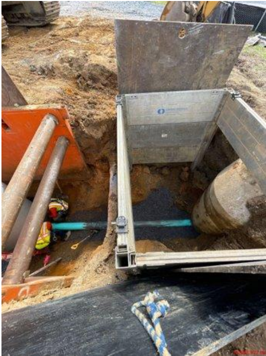
Conexión de tubería de MH 1 a MH 2.
