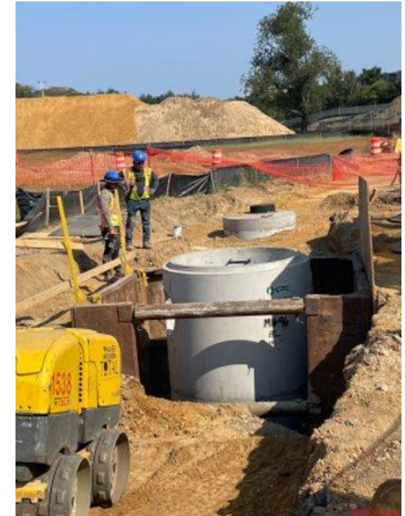
Instalación de la base intermedia del pozo de registro (MH) 96
