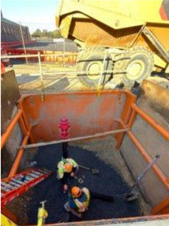
Instalación de nuevo hidrante
