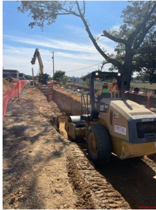
Compactación del suelo desde el pozo de registro (MH) 2 hasta la mitad del camino conector oeste.
