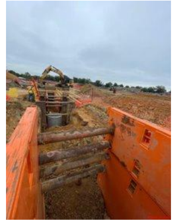
Travaux d'excavation près de MH 3.
