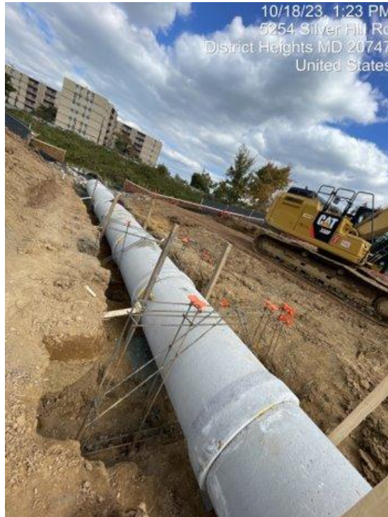
Installation d'une canalisation d'eaux pluviales de RS-2 à I-149
