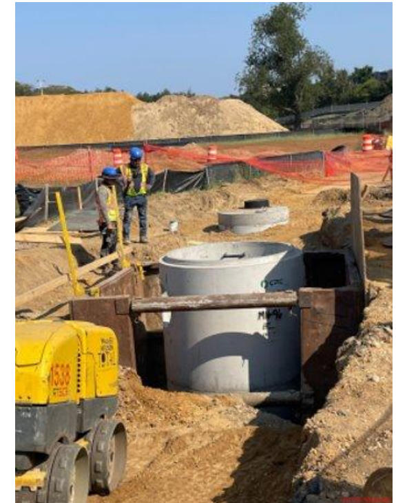
Installation de la base centrale de la bouche d'égout (MH) 96
