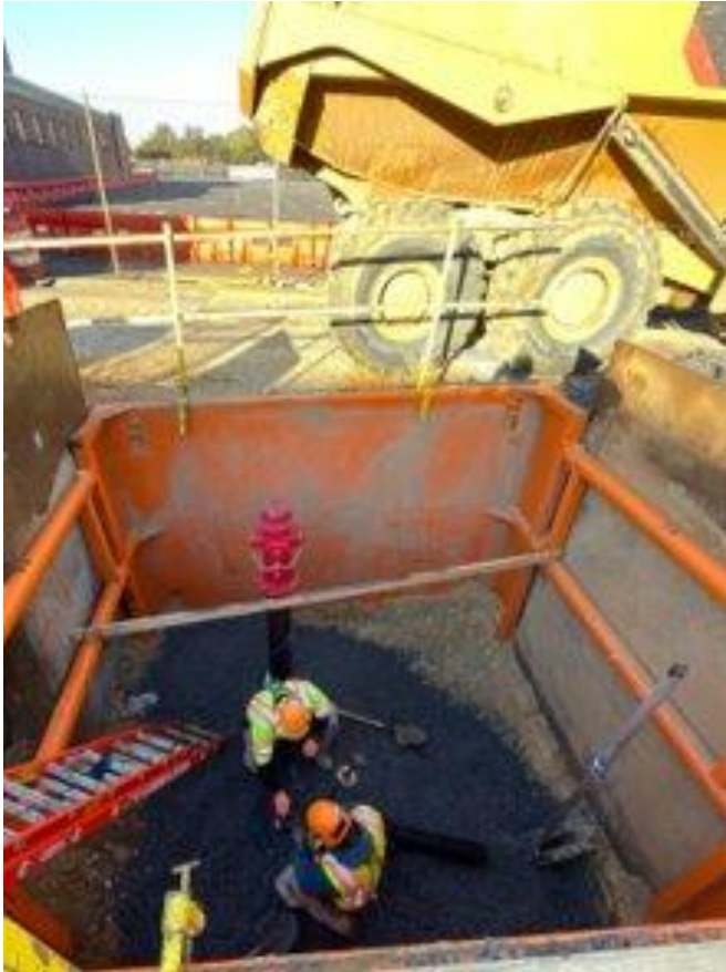
Installation d'une nouvelle bouche d'incendie
