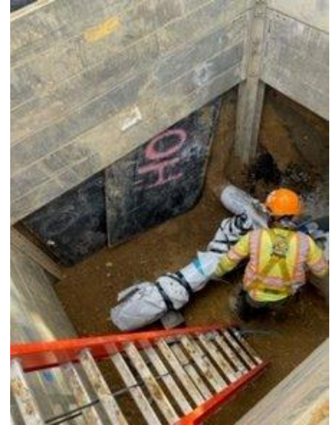
Raccordement de la conduite d'eau à la conduite existante
