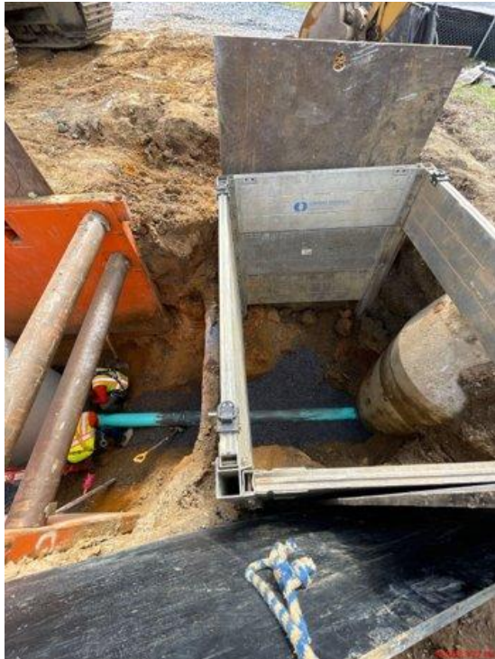
Raccordement des tuyaux de MH 1 à MH 2.
