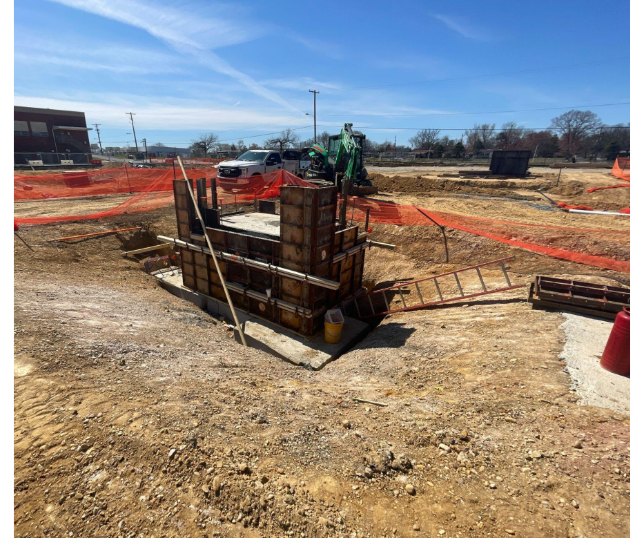
Foso del ascensor y bases de las escaleras 2
