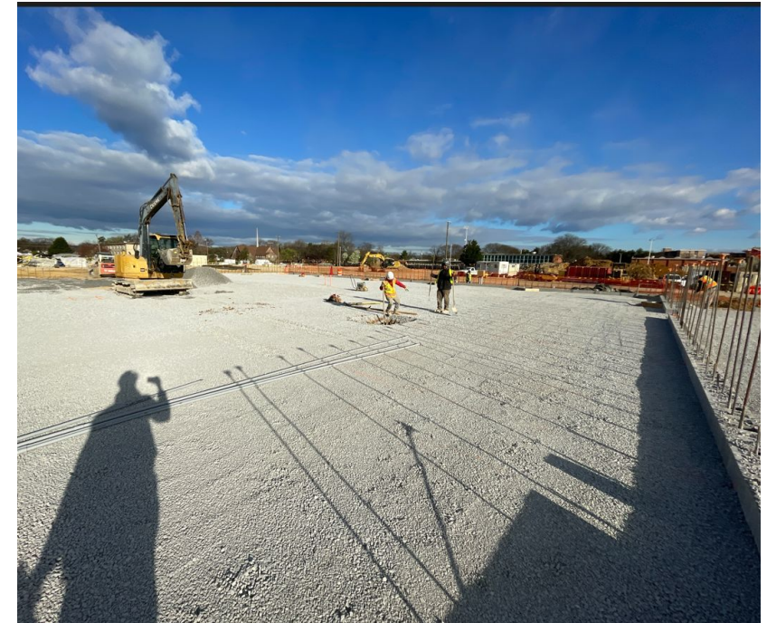
Preparación para la plancha de hormigón
