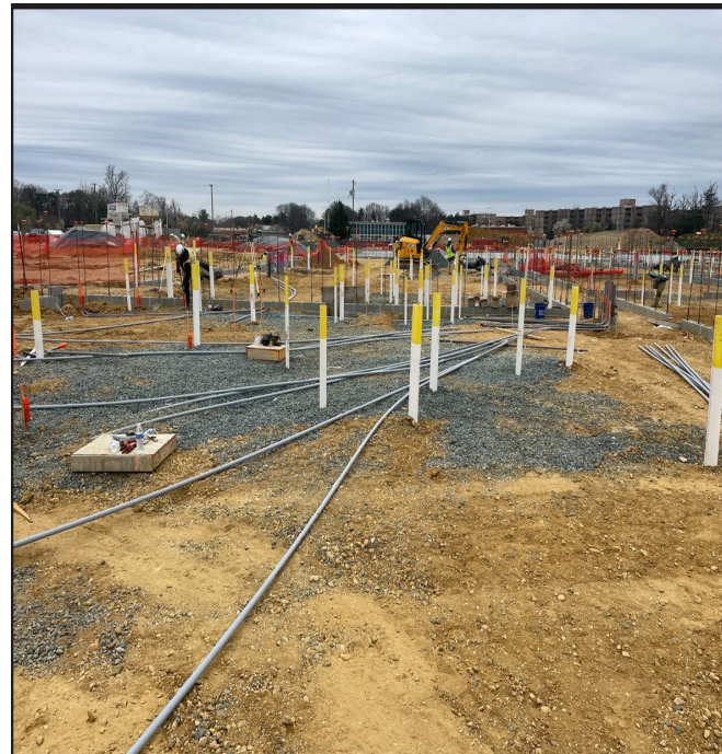
Mecánica, electricidad y plomería subterráneas
