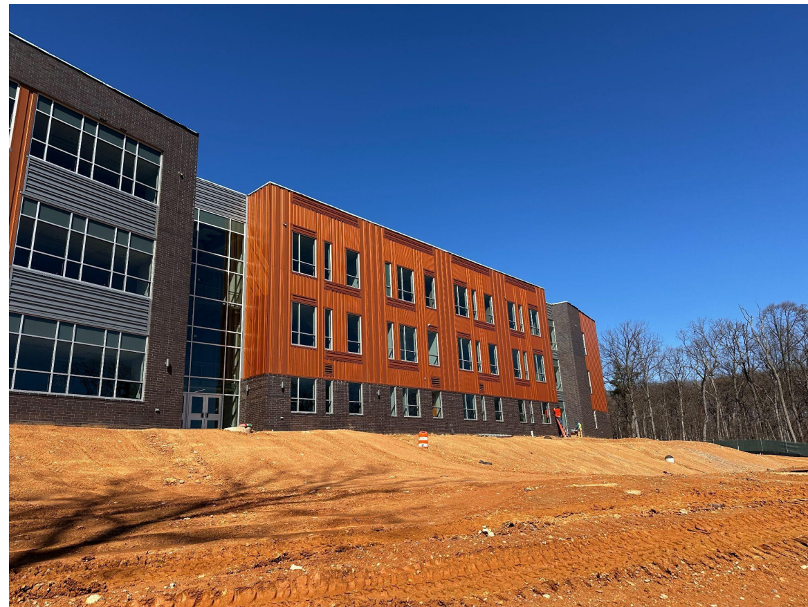
Continuación del ala del edificio con 3 pisos de aulas
