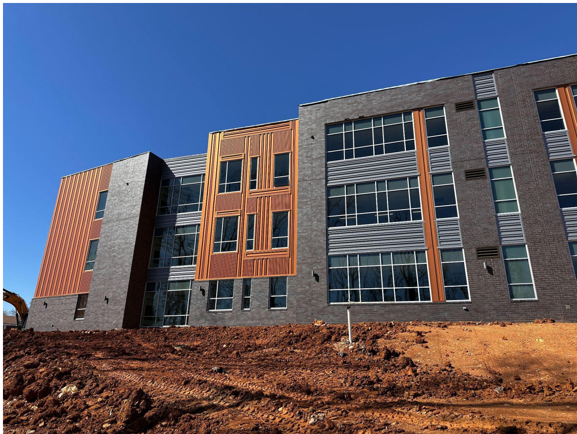
El lado este del edificio muestra las aulas en el ala de 3 pisos
