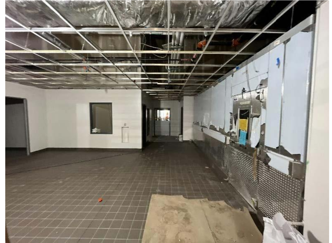
Toilette collective - Plafond fermé, Installation de plomberie
