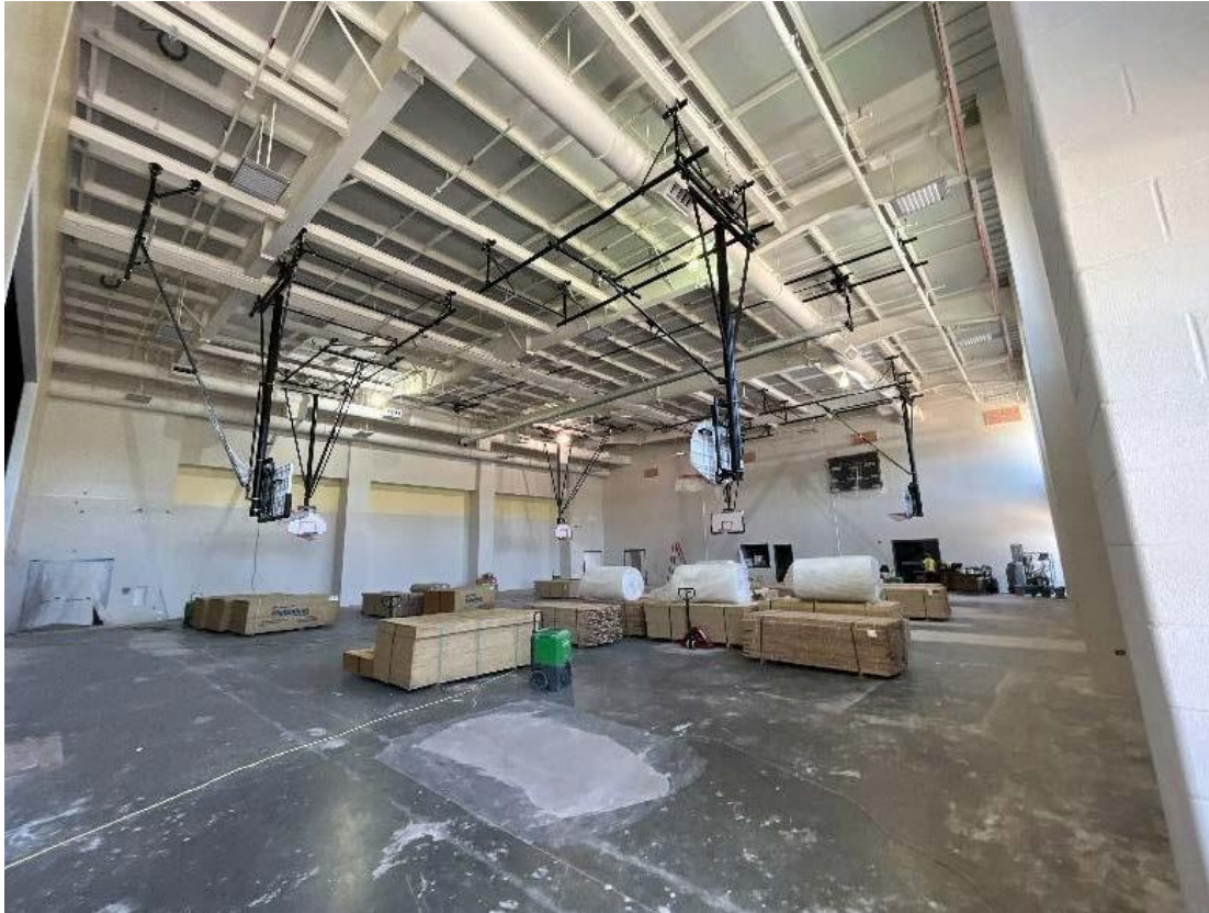
Préparation du sol du gymnase, installation d'un panier de basket-ball
