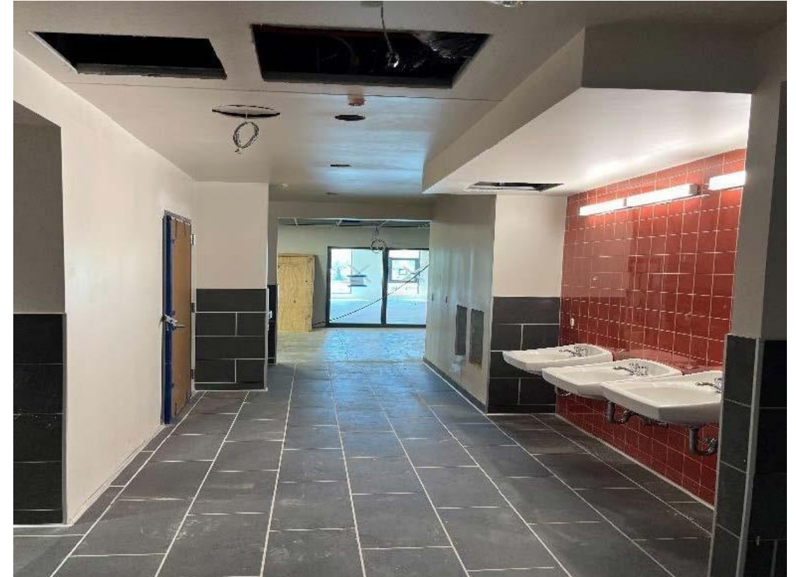
Toilettes collectives - Carreaux de céramique, pose de VCT
